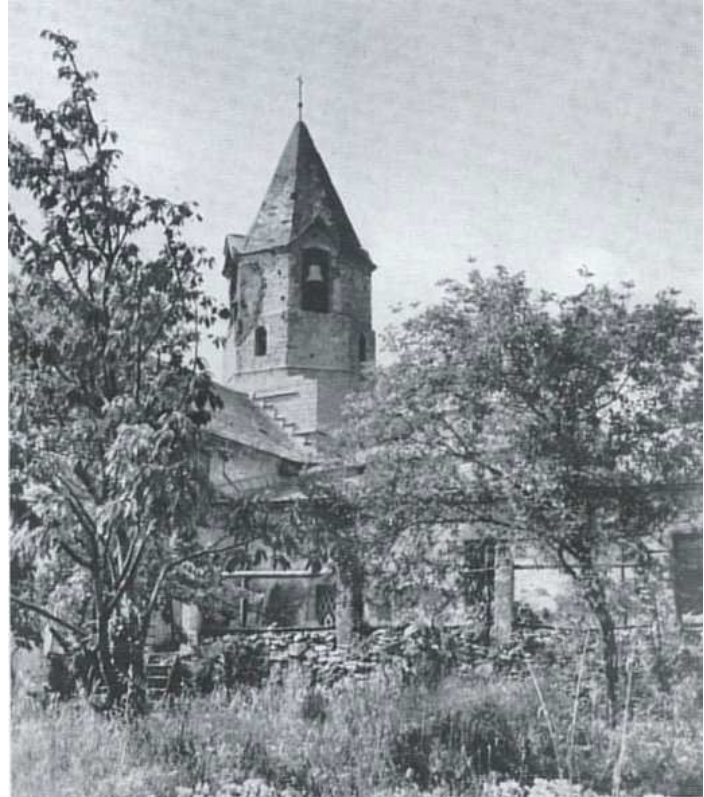
Fig. 11 - Campanile ottagonale (sec. XII) della chiesa di S. Bartolomeo della Costa di Sampierdarena.
