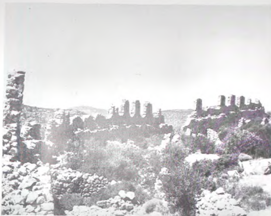
a - Ruines du Castrum d'Harmolia
