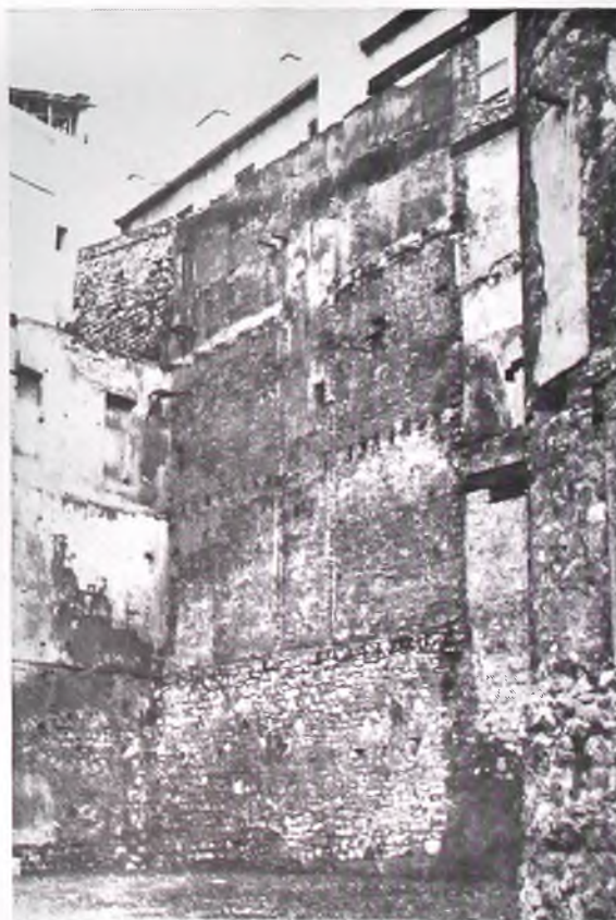
b - Restes du mur génois en arrière de l'église Saint-Pierre et Saint-Paul.
