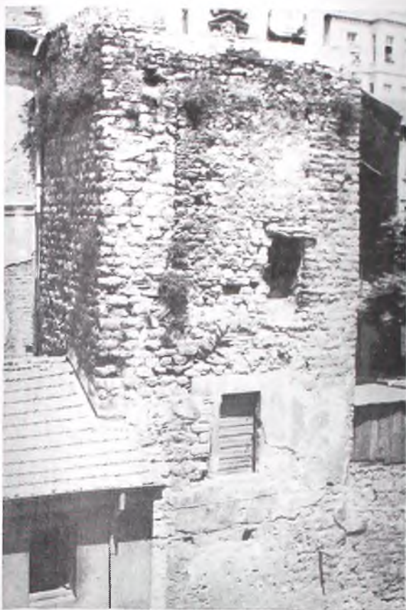
a - Tour de la rue Luleci Hendek (côté sud).
