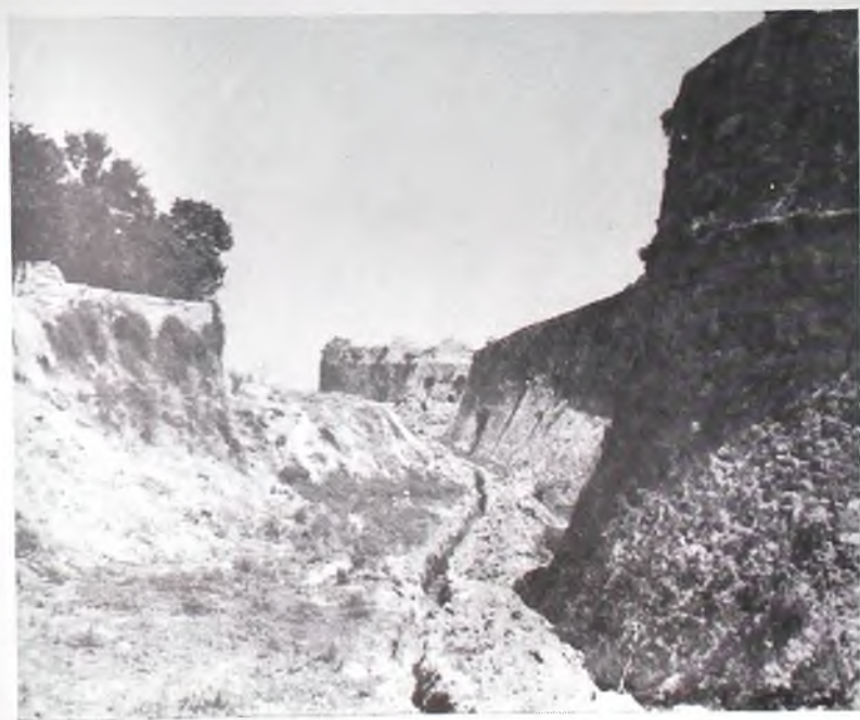
b - L'enceinte du Castrum (face nord-ouest)
