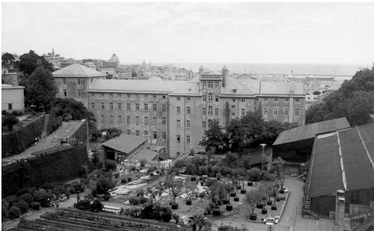
Fig. 6 - Albergo dei poveri, facciata di tramontana vista dall'attuale Corso Firenze.
