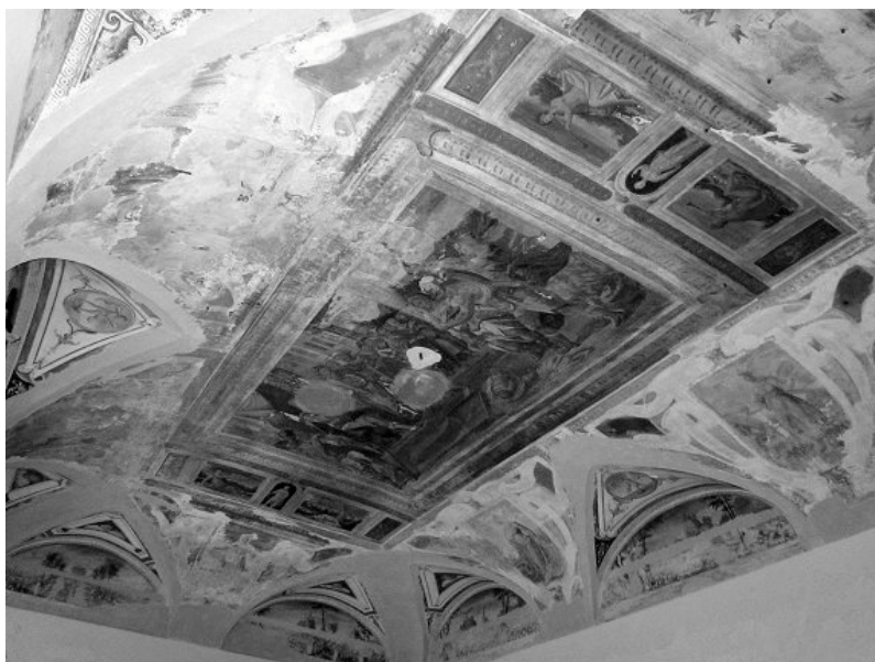
Fig. 13 - Secondo piano nobile. Appartamenti. Volta della sala.
